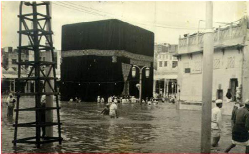
Ka'bah kebanjiran karena tidak ada saluran air
