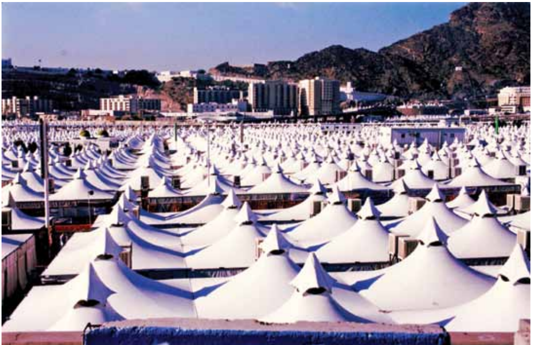
Tenda-tenda permanen yang dibangun pemerintah Arab Saudi di Padang Arafah dari bahan konstruksi tahan api, pembangunan tenda ini sebagai peningkatan fasilitas untuk para jamaah haji.
