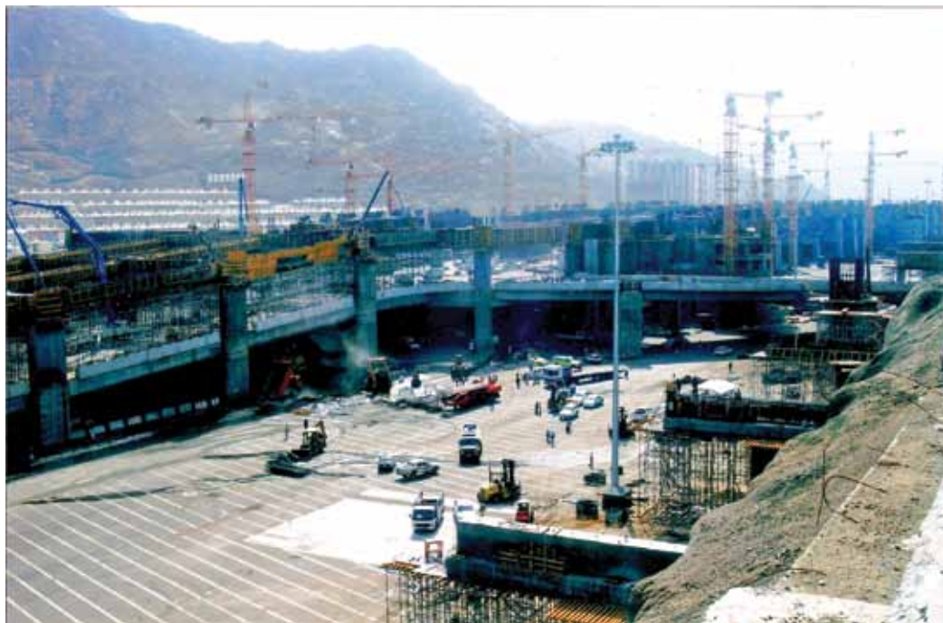
Tempat pelemparan Jumrah yang sedang dibangun kembali Pemerintah Arab Saudi dengan 5 lantai di Mina dari yang sudah ada hanya dua lantai.
